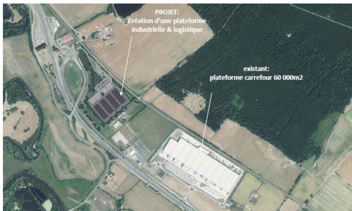
Figure 14 : Site et situation du projet dans son environnement proche, FIRE FACTOR'INDUSTRY.
